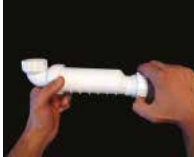
3- Hepvo® Koku Önleyici Diyafram çıkış tarafı ile rakor dışını çevirerek diyafram ile birleştiririz. Körük hortumunu çökerek montajın düzgün olup olmadığını kontrol ederiz.
