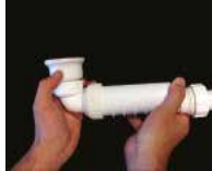
4- Lavabo süzgecinin dirseğin üst rakorunu ağzına saat yönünde çevirerek monte ederiz. Rakoru sıkarak contayı sıkıştırırız. d32'lik Hepvo® bağlantısı için kit içinde yer alan conta ayrıca kullanılmaktadır.
